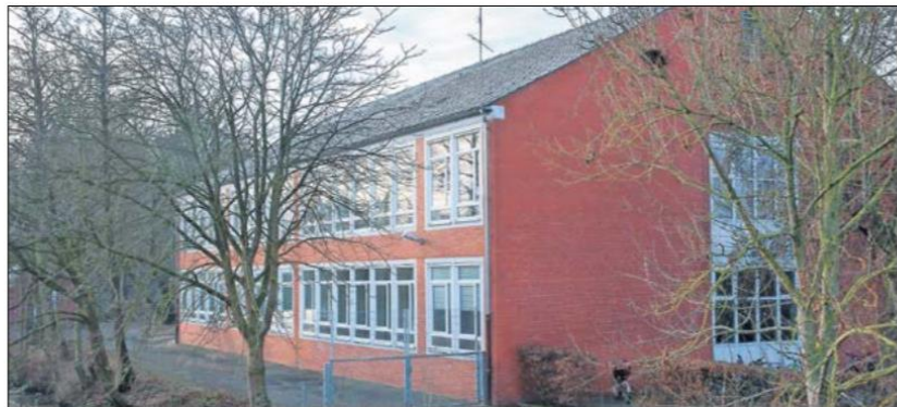
Kanaltrakt des Johannes-Althusius-Gymnasiums: Hier soll Anfang April mit dem Rückbau des Dachtragwerkes begonnen werden - danach wird um eine Etage aufgestockt.
