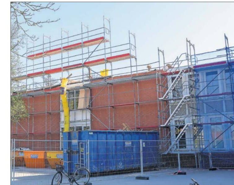
Das Dach ist schon weg. Der Umbau am JAG schreitet voran.
